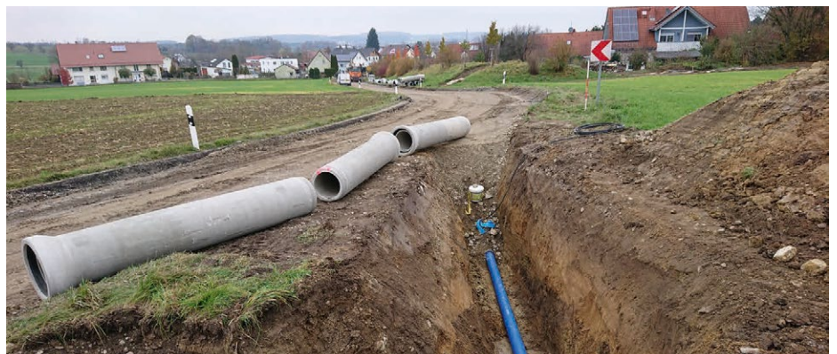
In Zollenreute (Stadt Aulendorf) wurde die Wasserleitung erneuert.
