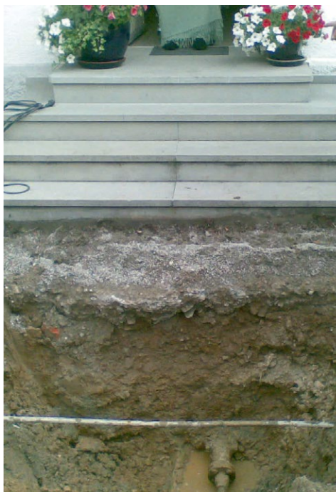
Wenn man am Haus Grabungsarbeiten verrichtet, ist es empfehlenswert, auch die Wasserleitung in den Blick zu nehmen. Foto: osg
