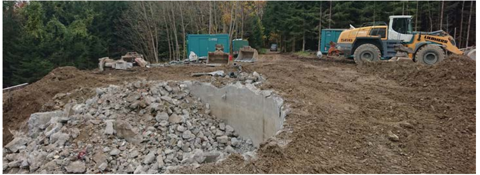
Eine Sanierung des aus den 1950er-Jahren stammenden Hochbehälters bei Kohaus (Volumen: 400 Kubikmeter) war wirtschaftlich nicht sinnvoll. Er wurde im Oktober 2020 abgebrochen. An seine Stelle kommt ein Ersatzbau mit einem Fassungsvermögen von 1900 Kubikmetern, der die zwei alten Behälter im Tannenbühl (2 x 250 Kubikmeter) sowie den HB Schnait (2 x 200 Kubikmeter) ersetzen wird. Foto: OSG
